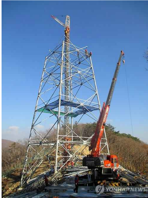
공사중인 밀양 765kV 송전탑
