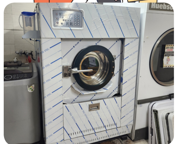
지하 1층 세탁실 세탁기 교체 (2024. 12. 24.(화))
